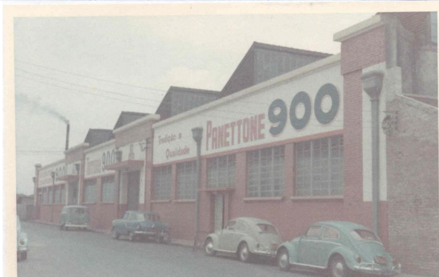
Foto 7: in alto, costruzione dello stabilimento dolciario a São Paulo, Brasile; in basso, lo stabilimento ultimato, 1956.
